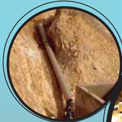
อ่างเก็บน้ำห้วยเหี้ย จ.เชียงราย กรมทรัพยากรน้ำ ท่อ 400 มม. PN 6 SN 5000
