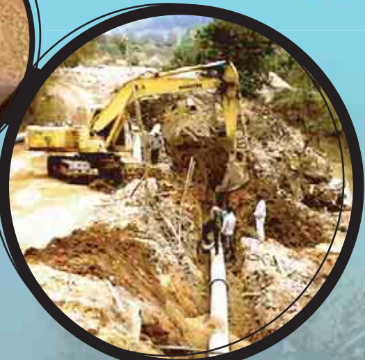
อ่างเก็บน้ำห้วยเหี้ย จ.เชียงราย กรมทรัพยากรน้ำ ท่อ 400 มม. PN 6 SN 5000
