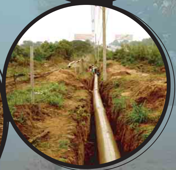
โครงการปรับปรุงขยาย การประปาสิริ นครราชสีมา กปภ. ท่อนขนาด 600 มม. PN 6 SN 10000
