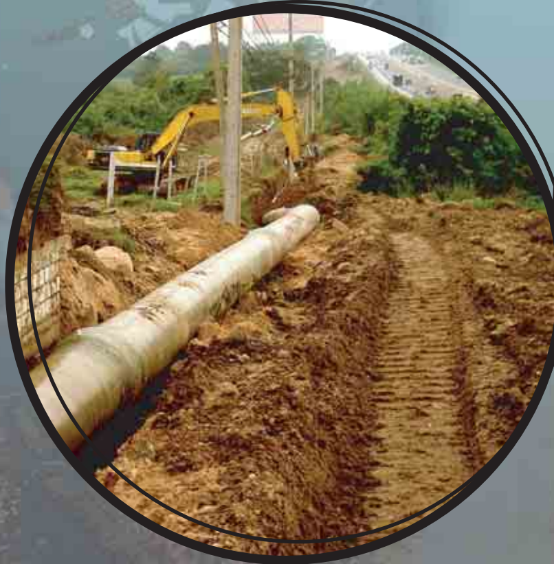
โครงการปรับปรุงขยาย การประปาสิริ นครราชสีมา กปภ. ท่อนขนาด 600 มม. PN 6 SN 10000
