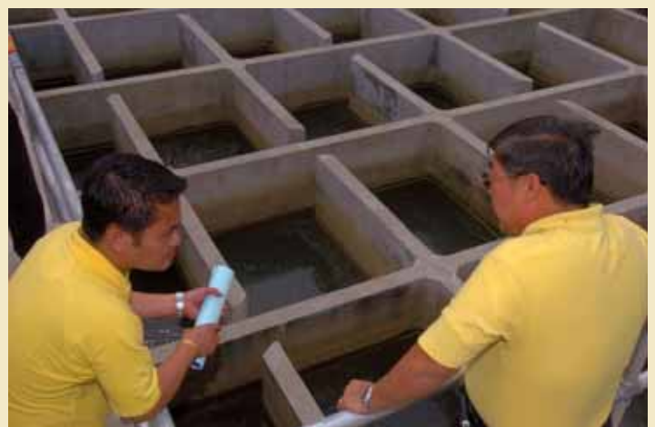
ตะกอนจึงถูกกำจัดออกไปตลอดเวลาทำให้ถังตกตะกอนมีประสิทธิภาพมากขึ้น (6 ธันวาคม 2549)
